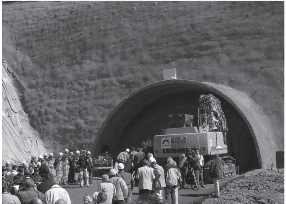
Tunnelanschlag am Höllberg
