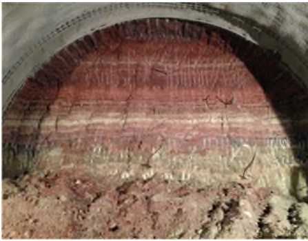
Ortsbrust im Ausgelaugten Gipskeuper Temporary Face in Leached Gypsum Keuper
