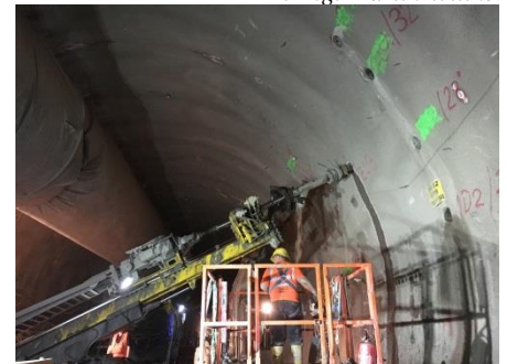
Tunnel nach Obertürkheim, Injektionen der Auslaugungsfront aus der benachbarten Röhre
