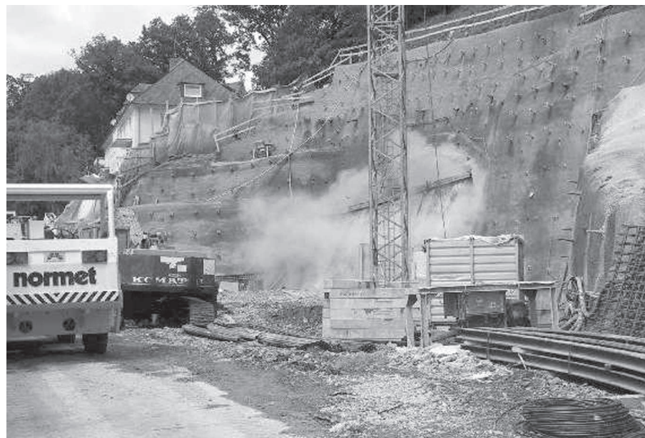
Anschlagwand während einer Sprengung, Gebäude K1 Portal wall during blasting, building K1
