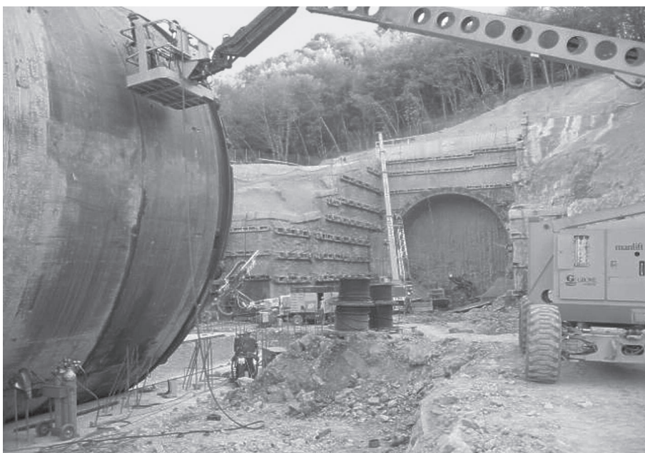
Anschlagwand Tunnel Collecervo / Portal Tunnel Collecervo
