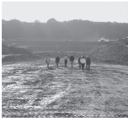
Schmücketunnel: Arbeiten im Voreinschnitt Nord Schmücketunnel: Works in the area of the cut at the Northern side of the tunnel
