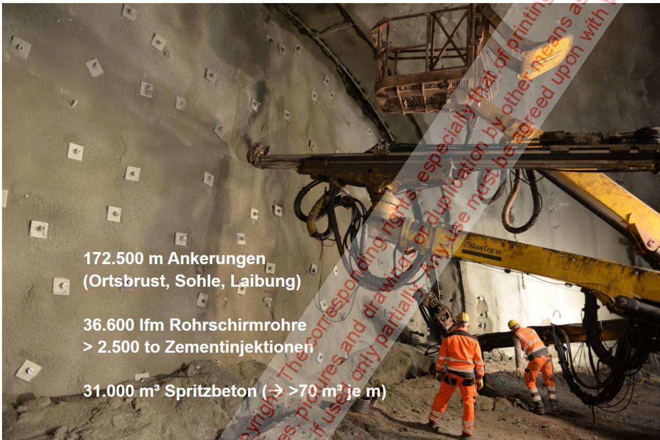
Bild 17: hoher Stützmittelmiteinsatz im Vortrieb Vollquerschnitt
