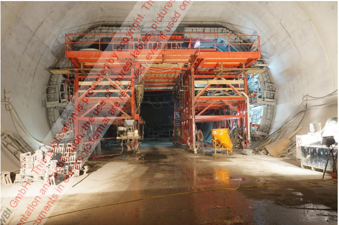
Bild 22: Schalwagen veränderliche Querschnitte
