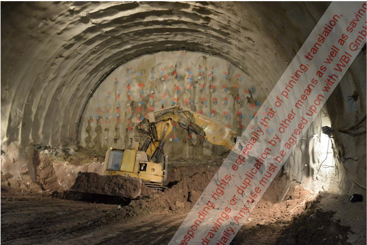
Bild 19: Baggervortrieb mit lokal ausgeprägtem Lockergesteinscharakter
