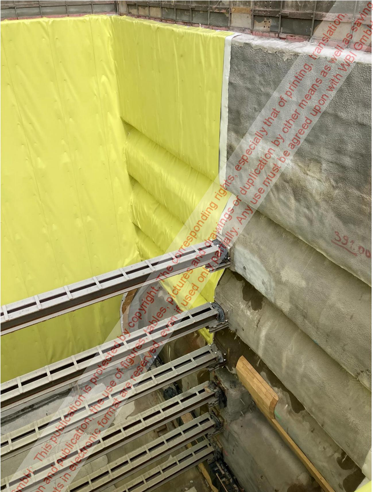
Bild 33: Zentraler Zugang, Technikgebäude West, Abdichtungsarbeiten
