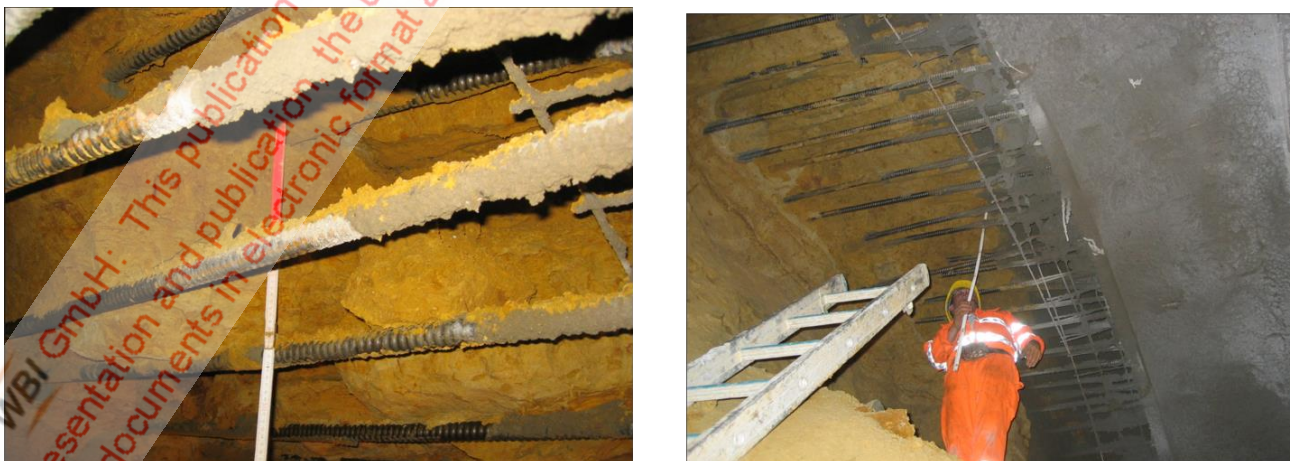
Bild 14: Vortrieb im Schutze von Spießschirmen - nicht möglich
