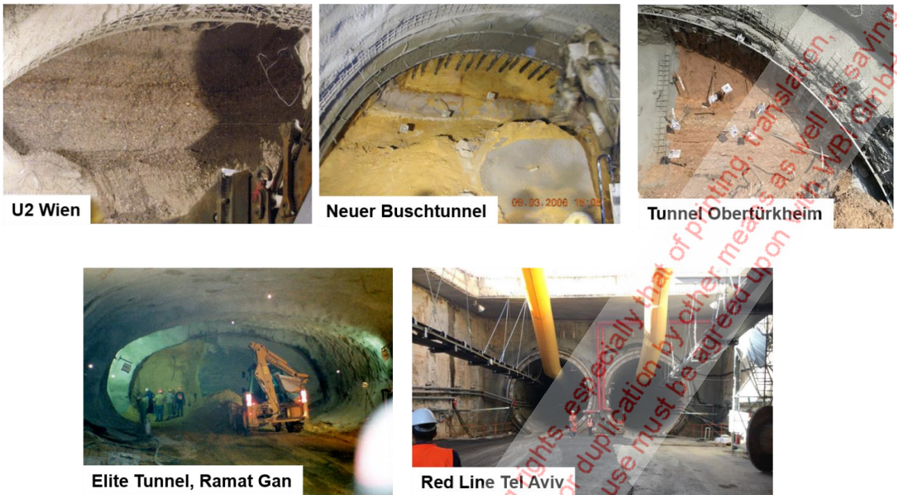
Bild 1: Beispiele für Vortriebe in grobkörnigen Böden.
