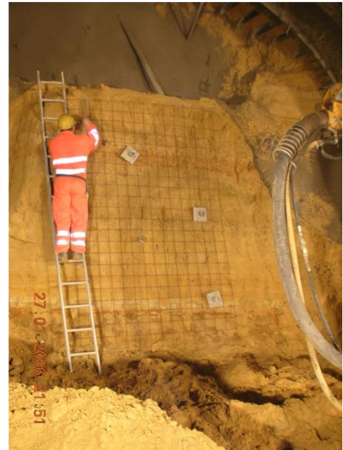
Bild 10: Feinsand, Buschtunnel, Scheinbare Kohäsion im Bereich Ortsbrust
