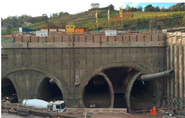
8 View on portal wall Kriegsberg Blick auf die Anschlagwand Kriegsberg
