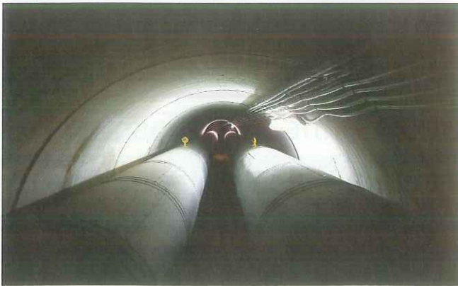
2 2-m-diameter jacking pipe with two 60-cm-diameter long-distance heat supply pipelines Pressrohr DN 2000 mit zwei DN 600 Fernwärmeleitungen
