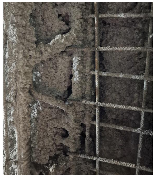
Bild 6: Risiko von Spritzschatten im Bereich von Bewehrungsstößen und Bögen
