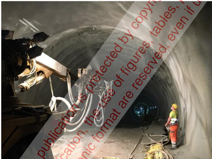
Bild 6: Risiko von Spritzschatten im Bereich von Bewehrungsstößen und Bögen
