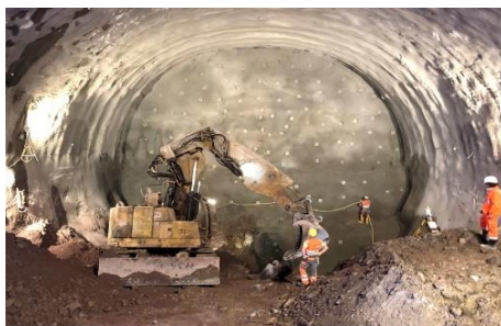
Großquerschnitt im Vollaussbruch aufgeföhren Grán sección excavada a sección completa
