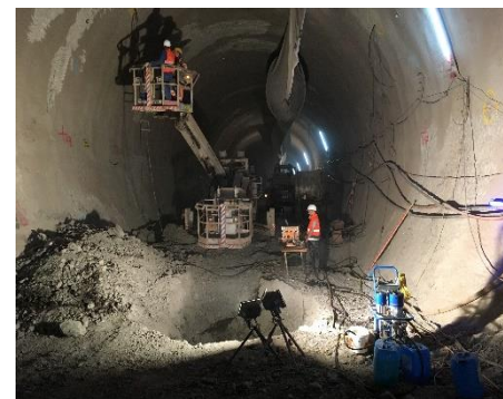
Ausführung der Durchlässigkeitsversuche Execución de ensayos de permeabilidad
