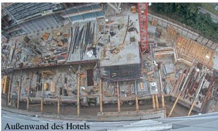
Bild 4 Sicherung der Bohrpfählwand durch Stahlsteifen
