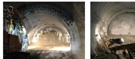
Bild 3 Rohrschirme und Vakuumanzlen
