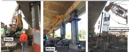
Bild 6 Pfahlherstellung Fig. 6 Pile construction
