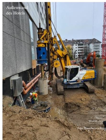
Bild 2 Bau der Bohrpfehlwand
