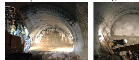
Bild 3 Rohrschirme und Vakuumlanzen
