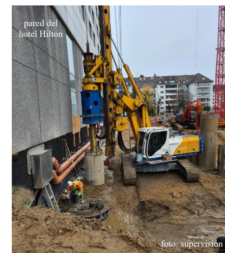
Bild 2 Bau der Bohrpflahlwand Fig. 2 Construcción del muro de pilotes perforados
