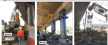
Bild 6 Pfahlherstellung Fig. 6 Construcción de pilas
