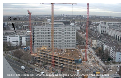
Bild 1 Eclipse Bauzustand, Hilton Hotel im Hintergrund Fig. 1 Eclipse Estado de construcción, Hilton en trasfondo der Eclipse liegt ca. 4 m tiefer als die Flachgründung des Hilton Hotels. Beide Gebäude sind auf Rheinkies gegründet. Der Grundwasserspiegel liegt unterhalb der Gründungssohlen.
