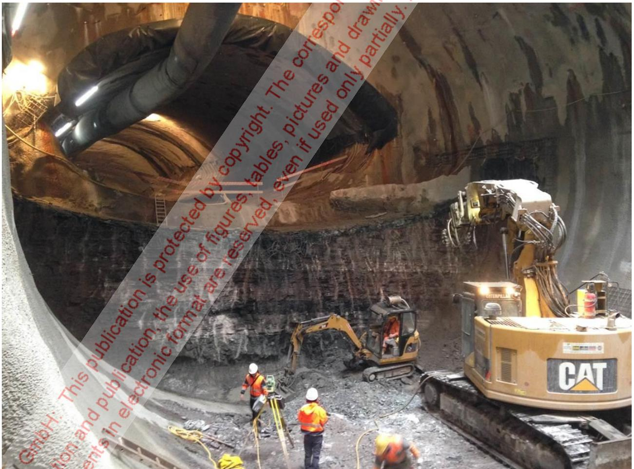
Bild 15: Strossen- und Sohlvortrieb im Bereich des Übergangs vom hohen auf den flachen Querschnitt
