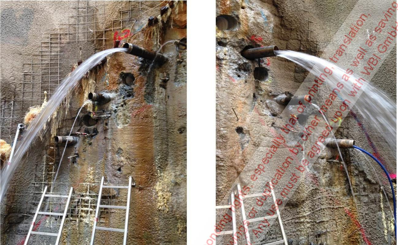
**Bild 5:** Wasserzutritte im Zuge der Rohrschirmherstellung
